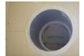
蓄熱エレメント設置
