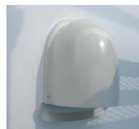
図⑫ 外部フード取付け
