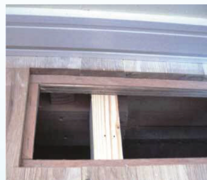
開口部施工写真
